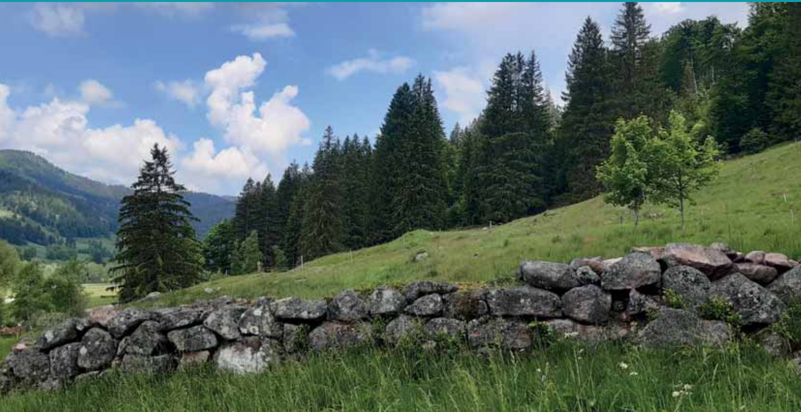
Die Sanierung der Trockenmauern im Biosphärengebiet Schwarzwald ermöglicht die Erhaltung wertvoller Lebensräume in Menzenschwand.
